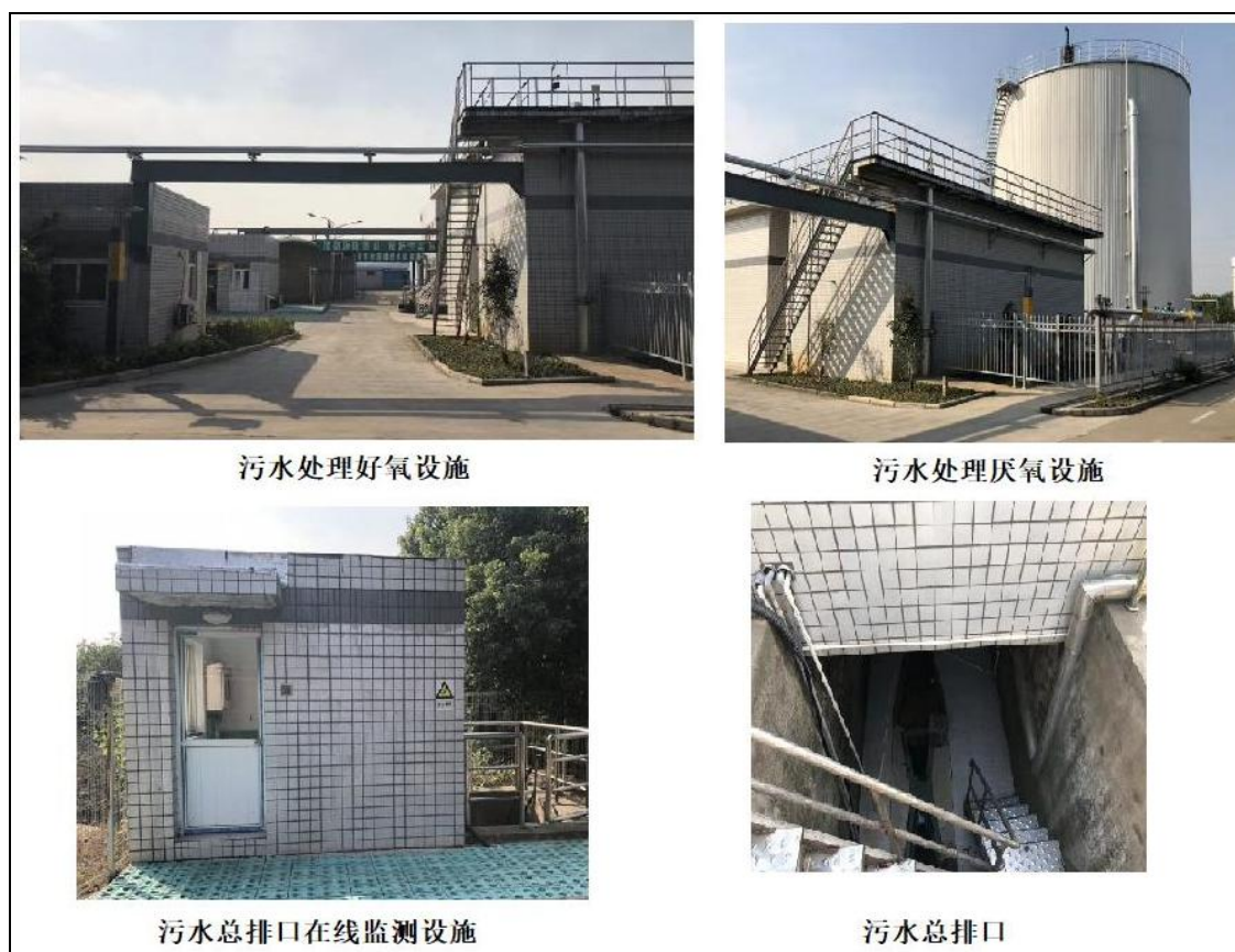
图 7.2-3 江苏恒顺醋业股份有限公司污水处理站现状图
